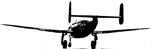
He 280 V7 ohne Triebwerke für Schnellflug-Messungen bei der DFS in Ainring.
